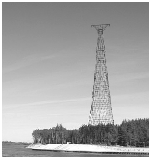
Рис. 1. Многоярусная гиперboloидная башня конструкции инженера В.Г. Шухова высотой 125 м на берегу р. Оки
